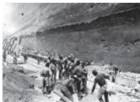
Izgradnja Korinskog kanala
